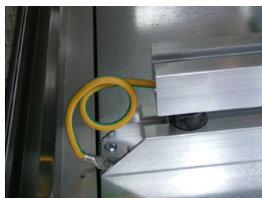
Cavallotto di terra su basamento ventilatore Earthing wire at fan base frame
